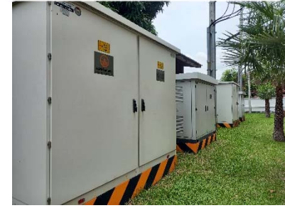
Ring Main Unit ของการไฟฟ้า
